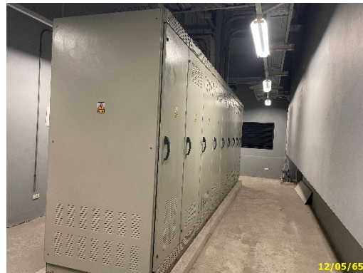
ระบบไฟฟ้าหลัก (MDB)
