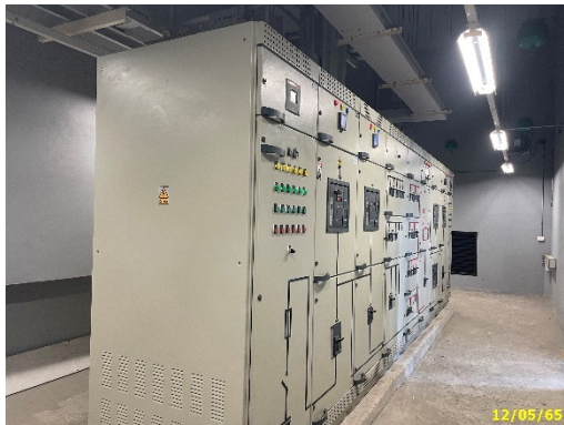
ระบบไฟฟ้าหลัก (MDB)
