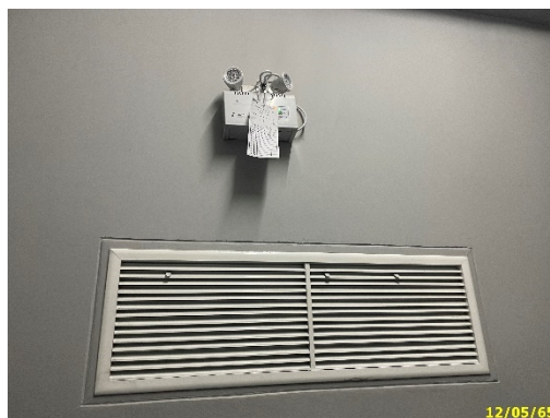
ระบบอัดอากาศภายในโถงลิฟต์ดับเพลิง
